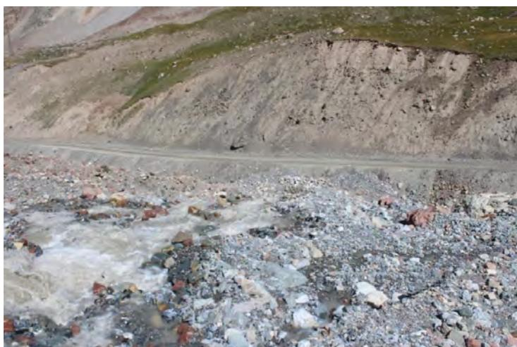
Рисунок 16 – Особо опасным является интервал 41.3-41.4 автодороги, против устья водотока стекающего с ледника №7, где могут образоваться мощные селевые потоки
