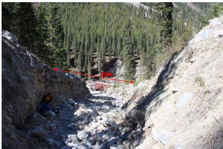
Рисунок 17 – На селевом лотке селесора 7л ширина фронта селевого потока на пересечении с полотном автодороги составляет 20-25м при глубине лотка 3-5м
