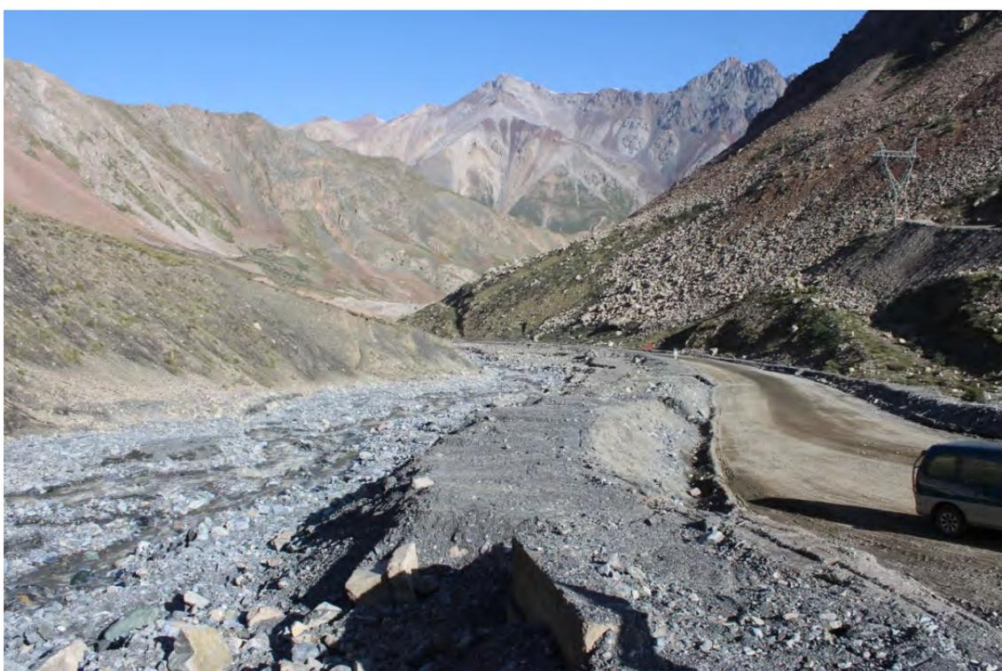
Рисунок 7 – Защитный вал надежно прикрывал полотно автодороги от паводков реки Сарымойнок до 4 августа 2019г в интервале 37,6-37,9км. После его размыва селевым потоком 4 августа 2019г он был восстановлен
