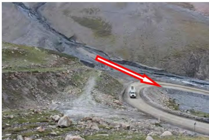
Рисунок 10 – Селевой поток 4 августа 2019г разрушил защитный вал (сейчас восстановлен) и завалил полотно автодороги на участке 37,6-37,9км грубообломочным материалом. Направление движения селевого потока показано стрелкой
