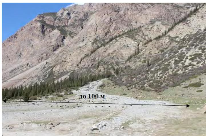
Рисунок 22 – На конусе выноса селесбора 3л ширина фронта селевого потока при его пересечении полотна автодороги составляет 40-100м
