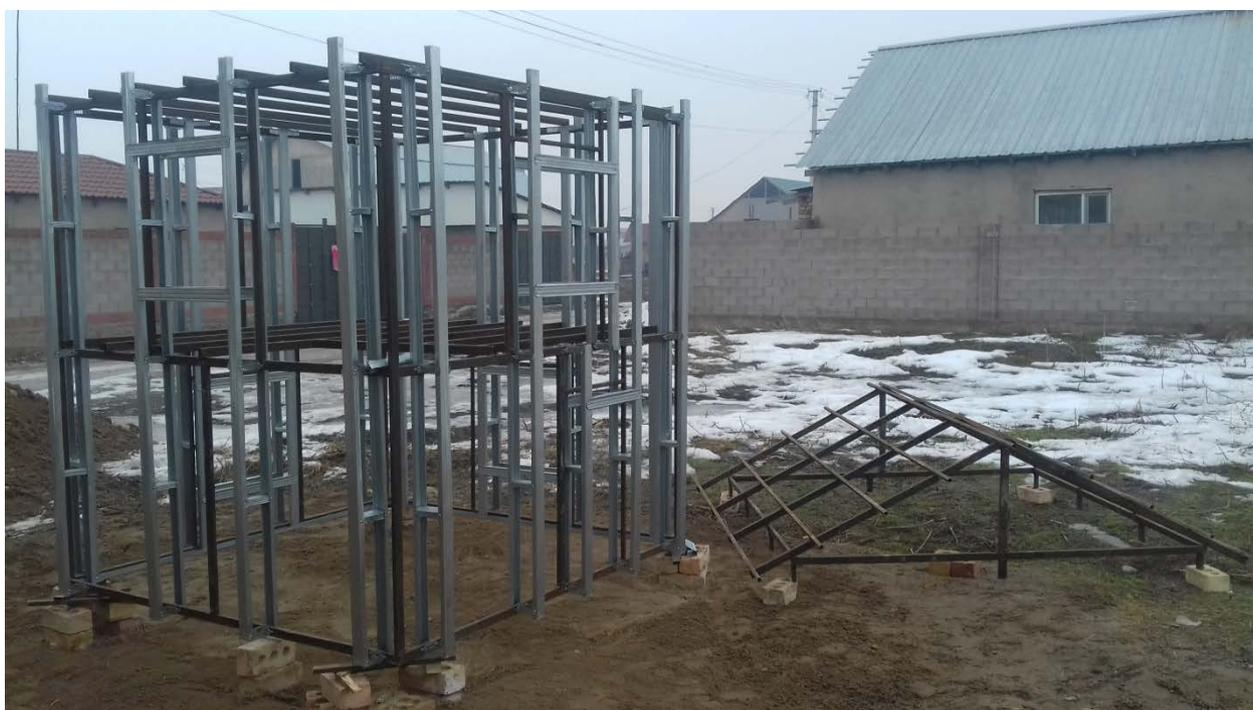
Рисунок 1 – Модель каркаса, выполненная в натуре.
